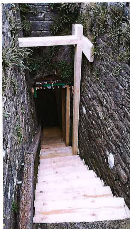
Escalier du puits à Grey après étaielement
