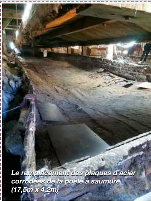
Le remplacement des plaques d'acier corrodées de la poêle à saumure (17,5m x 4,2m)
