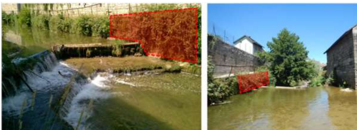
Photos du mur de soutènement prises depuis la rivière
