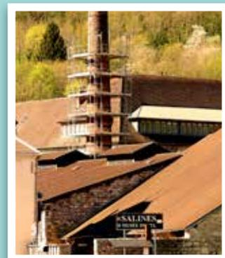
du couronnement sur une hauteur de 2,5m et des joints sur les 32m. La maîtrise d'œuvre a été confiée à l'atelier Cairn, et les travaux de maçonnerie à l'entreprise Jacquet. L'entreprise Nouveau (Salins) a mis en place la plateforme servant de base à l'échafaudage. Le coût des travaux - près de 220 000€ - a été subventionné à 80% par la DRAC (Direction Régionale des Affaires Culturelles), la Région et le Département du Jura.
