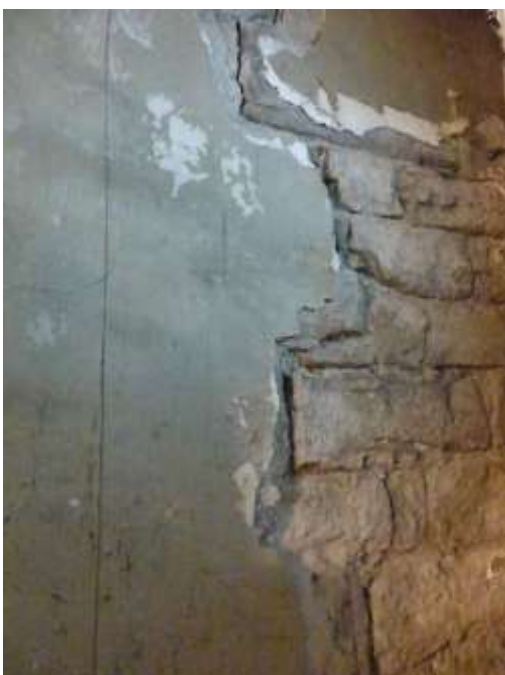
Fissure montant vers la corniche, au point de raccord Nord-Ouest avec la sacristie
