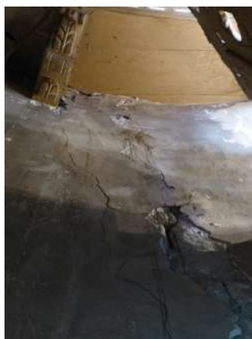
Fissure montant vers la corniche, au point de raccord Nord-Ouest avec la sacristie
